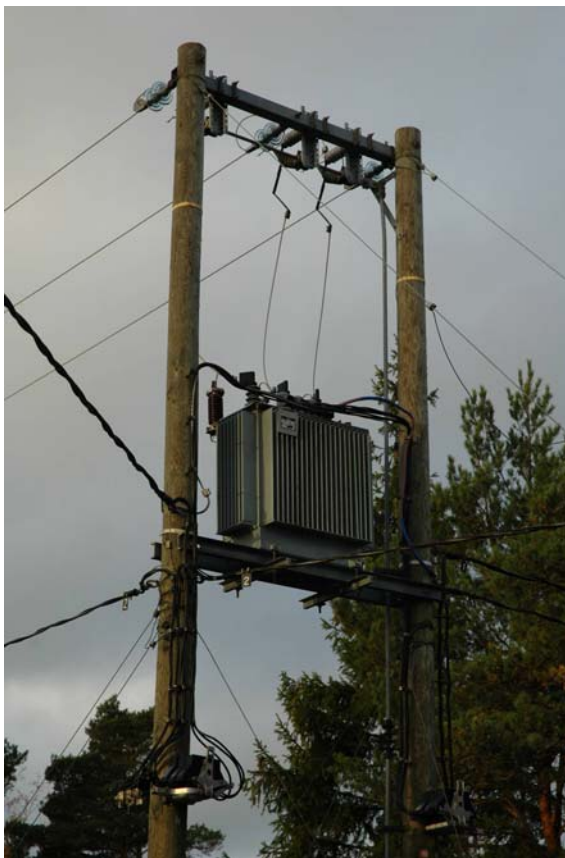
Kuva 2. Sähköpylväs ennen suojausta (Kustavi)
