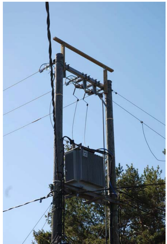
Kuva 3. Sama sähköpylväs orsisuojauksen jälkeen
